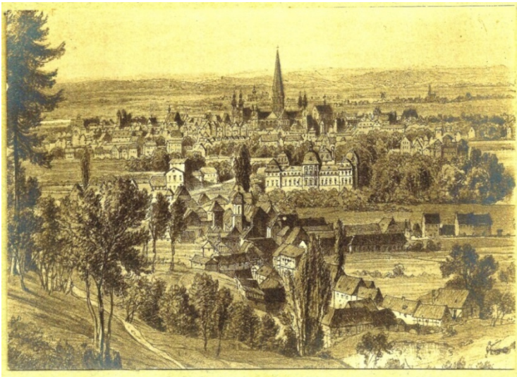
Blick vom Kreuzberg auf die Untere Mühle am Ortsausgang von Poppelsdorf
