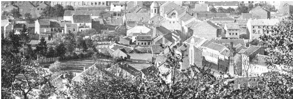
... und oberhalb der Trierer Straße (Foto 1882) ....
